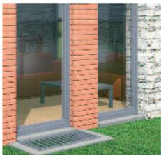
Le soupirail est un élément qu'on oublie souvent dans un plan de sécurisation d'une habitation. Attachez le soupirail à l'aide d'une chaîne avec cadenas. La chaîne doit être fixée le plus bas possible. Vous pouvez également opter pour l'installation d'une grille ou de barres intérieures (espace maximum entre les barres : 10 cm).
