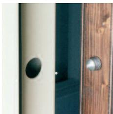
Il s'agit d'un pêne anti-dégondage qui augmente le degré de sécurité de la porte. Il est fixé sur l'ouvrant et lorsque la porte se ferme, il s'engage dans le dormant. Les charnières peuvent également être équipées d'ergots de sécurité empêchant leur soulèvement..
